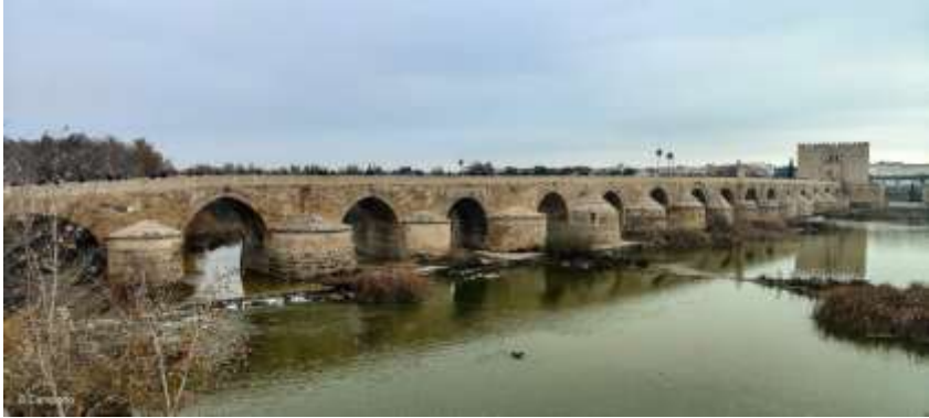
Puente Mayor de Córdoba. Fotografía: J. S. Campano. 2023.
